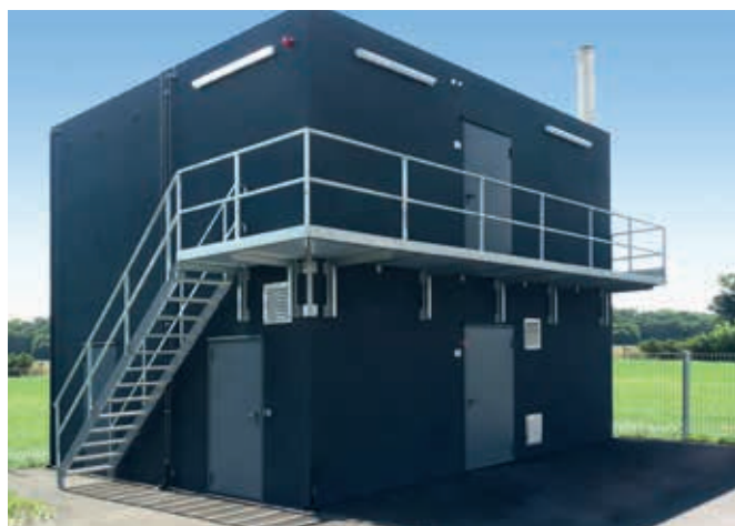
4-х модульна котельня на трісці на промисловому підприємстві
