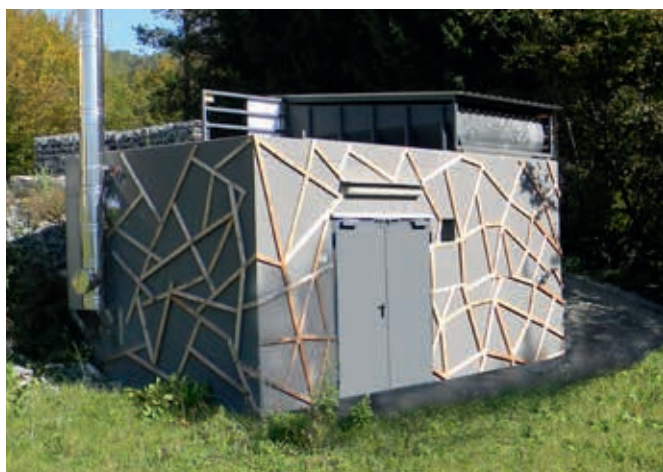
Одноповерховий модуль неподалік житлового будинку
