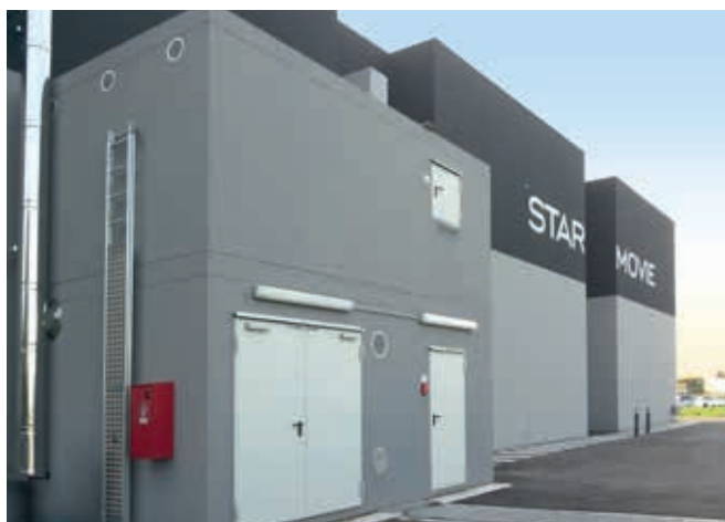
Двоповерхова модульна котельня на трісці біля підприємства
